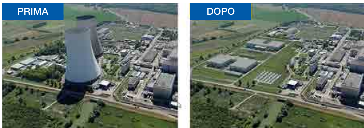
FIGURA 29 Sito esistente della centrale nucleare di Filisburgo dismessa per costruire le Stazioni di Conversione
