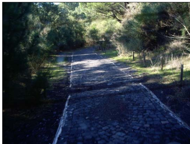
Fig. 60: Pavimentazione stradale a cubetti
