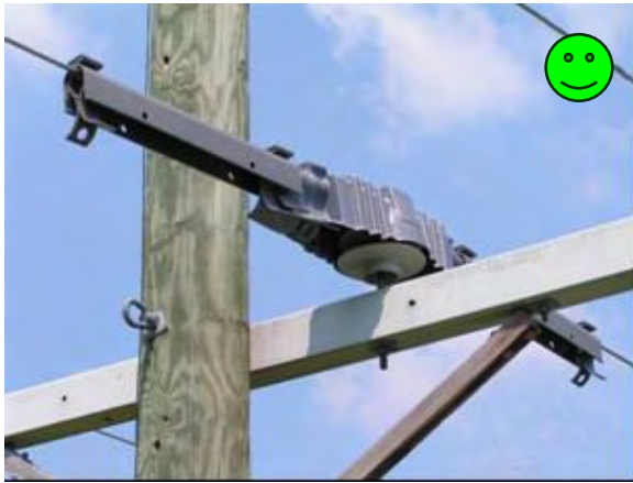
Fig. 47: Isolanti per isolatori portanti.
