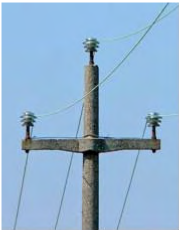
Fig. 10: Isolatore portante semplice.
