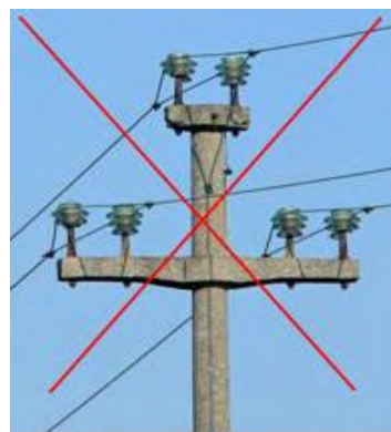
Fig. 67: Isolatore portante.
