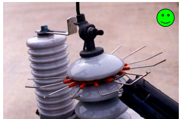
Fig. 50: Raggera di punta metalliche.
