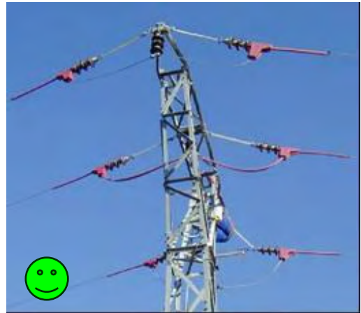
Fig. 48: Isolanti per isolatori per amarro.
