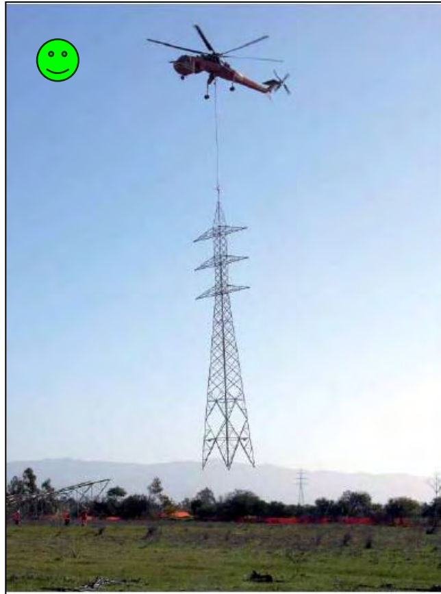
Fig. 37: Rimozione di linea AT - Foto Terna S.p.A.
