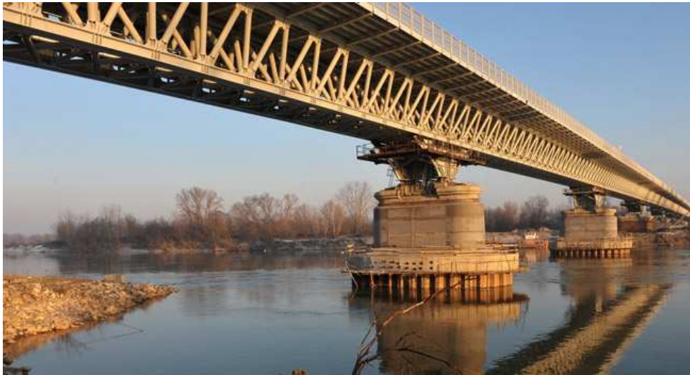
Figura 1. Ponte sul fiume Po realizzato in acciaio
