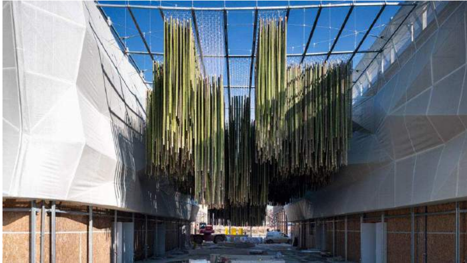
Figura 13. Cluster Isole in cantiere: fasi di completamento
