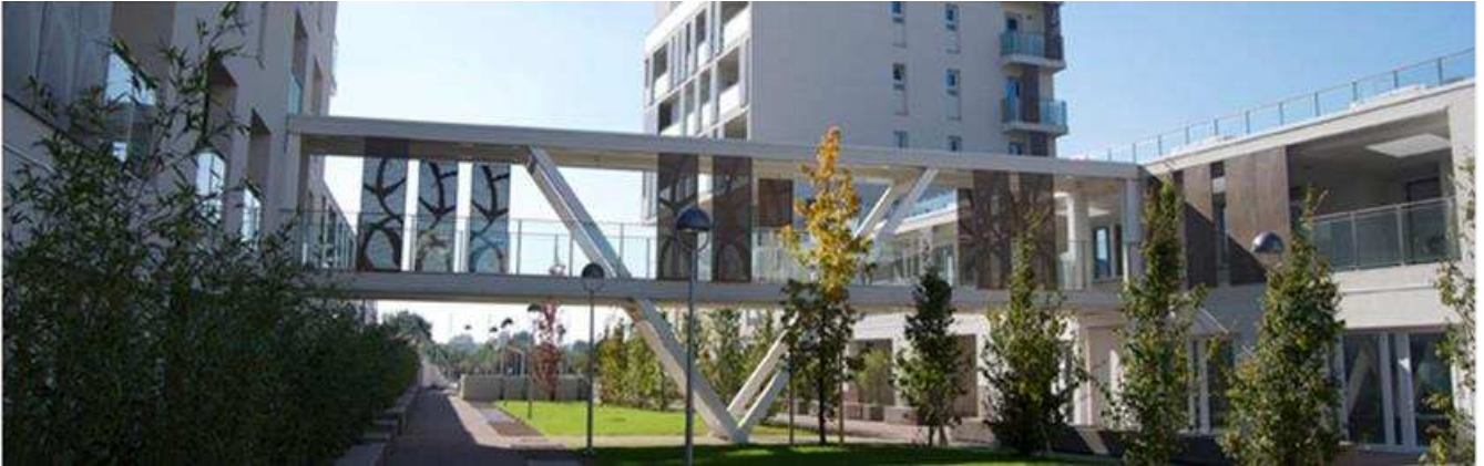
Figura 8. Edificio di Via Cenni a Milano (fonte: http://www.fondazionearonlus.org/progetti/foyer-di-cenni/ )
