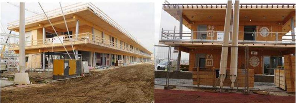
Figura 11. Esempio di architetture di servizio. Fonte: http://www.expocantiere.expo2015.org
