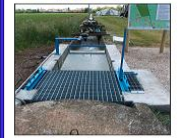
Demolizione irregola nel campo prova di Busca di Montebelluna (Foto: Stefania Benti)
