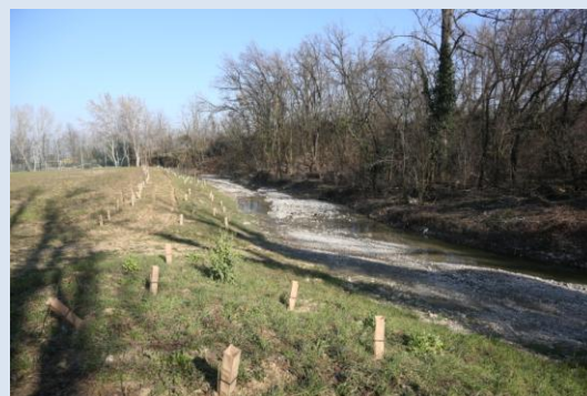
Nuova area allagabile ottenuta per risagomatura ed allargamento di sezione nel tratto del Rio Lavezza nei pressi del campo sportivo di Albinea (RE) (foto: B. Boz).
