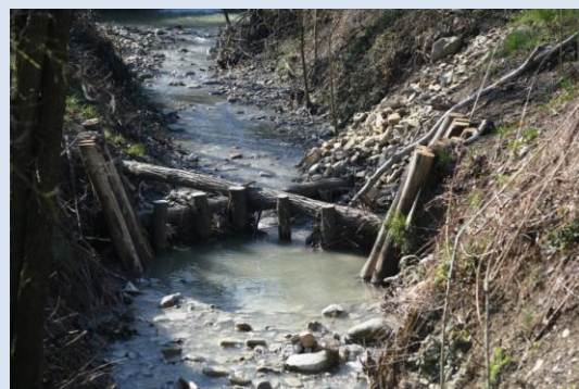
Esempio di briglia naturaliforme realizzata nel tratto collinare del Rio Enzola (foto: B. Boz).
