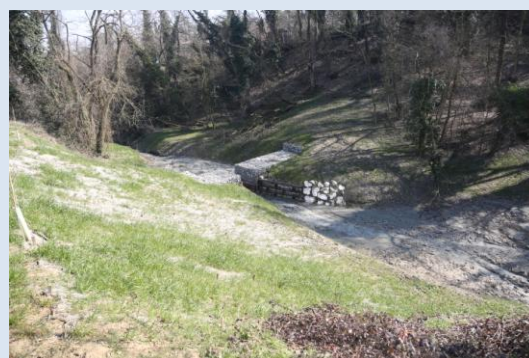
Il restringimento in pietrame rinverdito realizzato nel tratto collinare del Rio Bianello nella primavera 2015. È possibile vedere il rinverdimento delle sponde e la dinamica fluviale innescata a monte dei gabbioni all'interno della nuova area golenale (foto: B. Boz).
