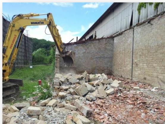
Foto 7 Demolizione fabbricato SO.TE.MI. (Foto: S. Picchi)
