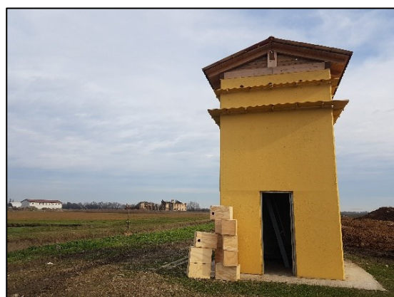
Figura 7: Torretta di nidificazione LIFE FALKON di Poggio Rusco (Mantova), durante le operazioni di installazione delle cassette nido al suo interno. (Foto: LIFE FALKON)
