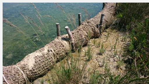
Fig. 5 – La vegetazione delle barene colonizza velocemente il fango riportato dietro le fascine, rinforzando il suolo con le proprie radici (Foto: staff di LIFE VIMINE)
