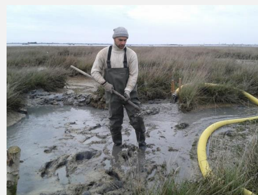
Fig. 4 – Micro-refluimento di sedimento dietro le fascine per ricostruire una porzione erosa di barena (Foto: staff di LIFE VIMINE)
