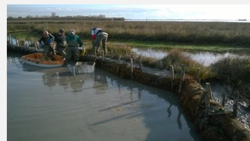
Fig. 7 – Pescatori in laguna mentre costruiscono gli interventi di ingegneria naturalistica contro l'erosione (Foto: staff di LIFE VIMINE)
