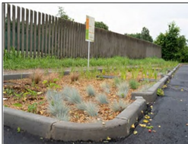
Figura 5: Solaro, realizzazione aiuola drenante in area di parcheggio auto. (Autore: Michele Maggi, Legambiente Lombardia)
