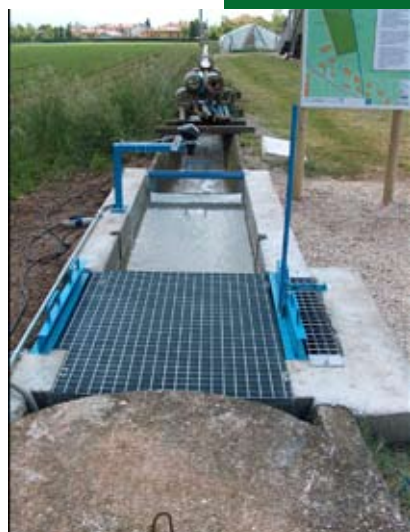
Stazione di misura della portata di ingresso nella canaletta di adattamento del campo di prova per la ricarica artificiale della falda a Busta di Montebelluna (Treviso) (Foto Stefania Betti)
