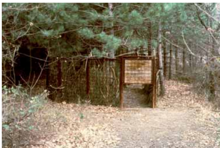
Figura 2 – Chiusino mobile costituito da pannelli modulari rettangolari di rete elettrosaldata assemblati mediante filo di ferro.
